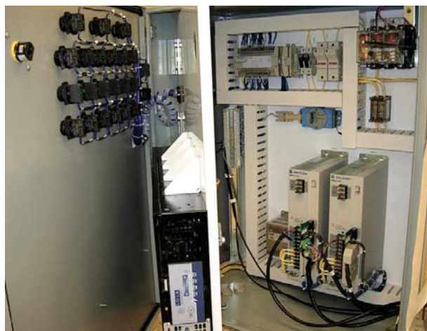
Componentes internos del controlador remoto del accionador de la válvula
